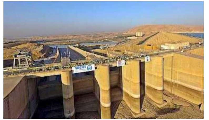
La conclusione dei lavori di consolidamento della diga di Mosul in Iraq
