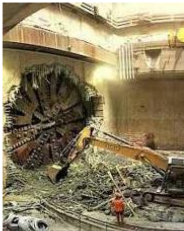
Gli scavi per la metrò Gran Paris Express
